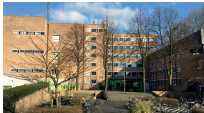
Voormalig KPN-gebouw De Telefooncentrale langs de N242 is een voorbeeld van een pand dat na jarenlange leegstand succesvol is getransformeerd tot een bedrijfsverzamelgebouw voor de creatieve industrie.
