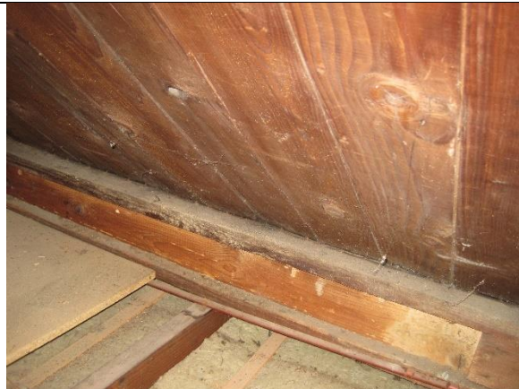
Grote luchtlekken over de gehele aansluiting van de dakvoet
