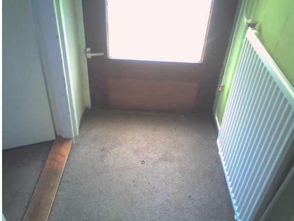
Grote luchtstroom onder de voordeur door ontbreken kierdichting
