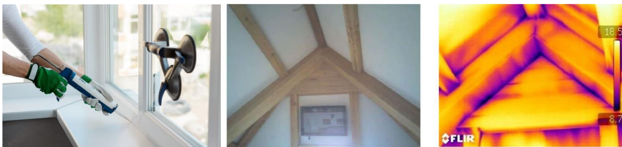
Figuur 10: Aandacht voor glasvervanging en luchtdichtheid bij renovatie (bron: Nieman RI)
