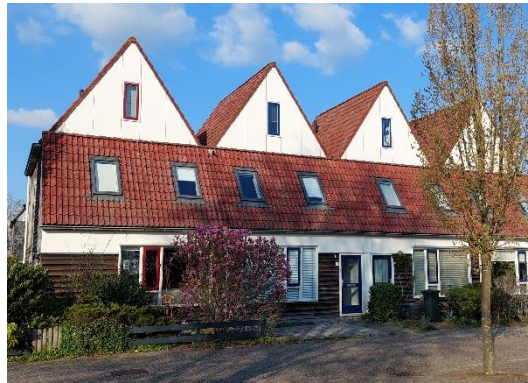
2. Hoekwoning met dwarskap (jaren '80)
