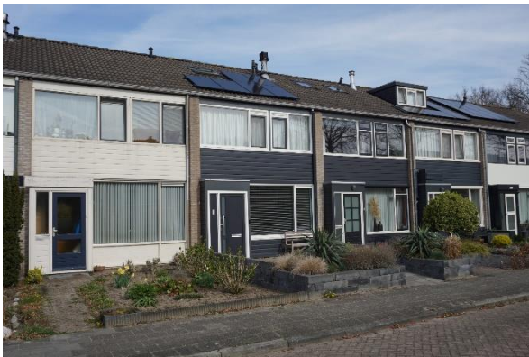
Figuur 5: Tussenwoning met gevelvullende elementen jaren '60/'70 (bron: Nieman RI)
