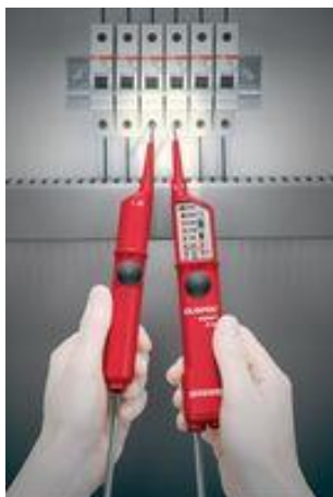
Figuur 180 Meten met een dubbelpolige spanningsaanwijzer (Duspol)
