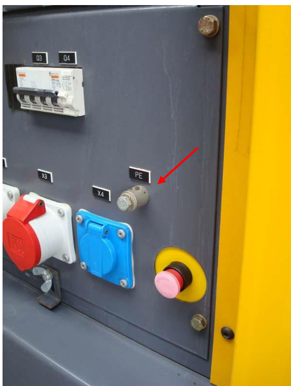
Figuur 119 Aansluitmogelijkheid voor de aardleiding (zie de rode pijl)
