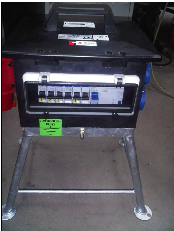
Figuur 138 Aardnok op de bouwkast
