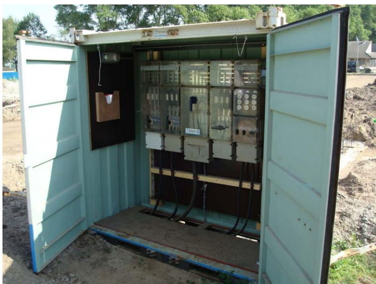
Figuur 131 Een stalen (omhulsel) container moet worden verbonden met de aardrail van de elektrische installatie
