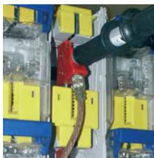
Figuur 193 Aardingsgarnituur; dikke litzedraad om alle geleiders onderling te koppelen
