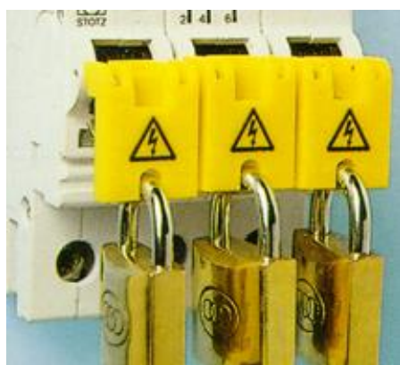
Figuur 189 Borging op een installatieautomaat
