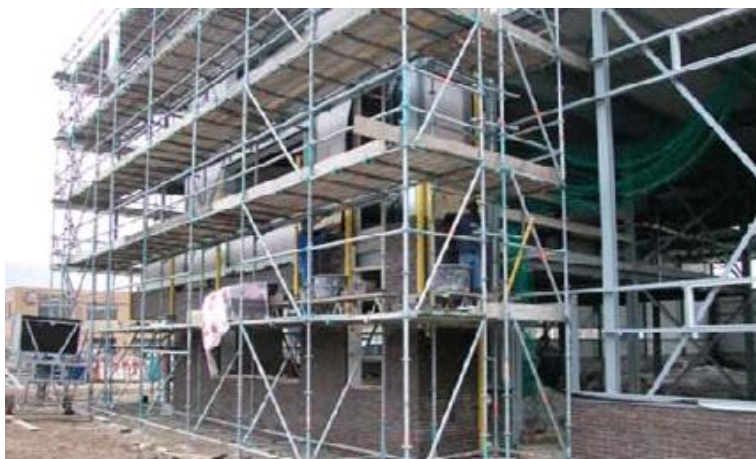
Figuur 134 Stalen steigers moeten worden geaard
