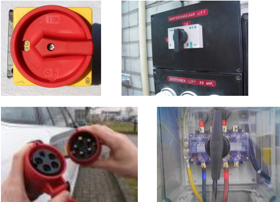
Figuur 187 Scheiden met een lastseparator: werkschakelaar, hoofdschakelaar of contactstop
