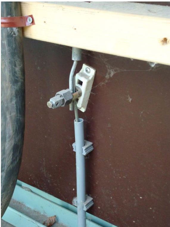
Figuur 126 De verbinding tussen een aardelektrode en een aardleiding moet een goede verbinding vormen
