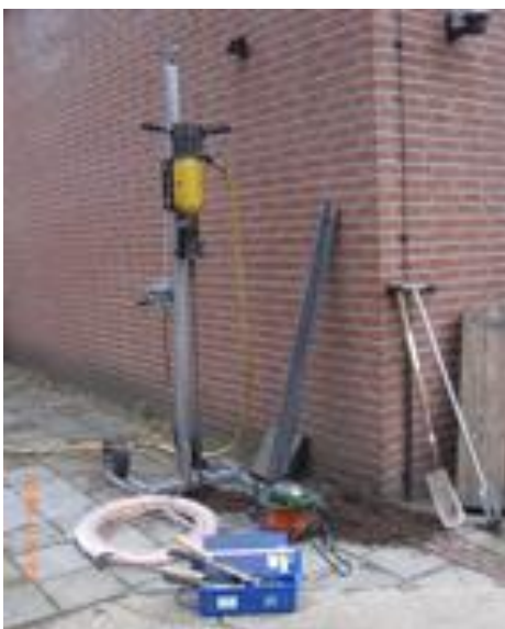
Figuur 110 Indrijven van een staafvormige aardelektrode
