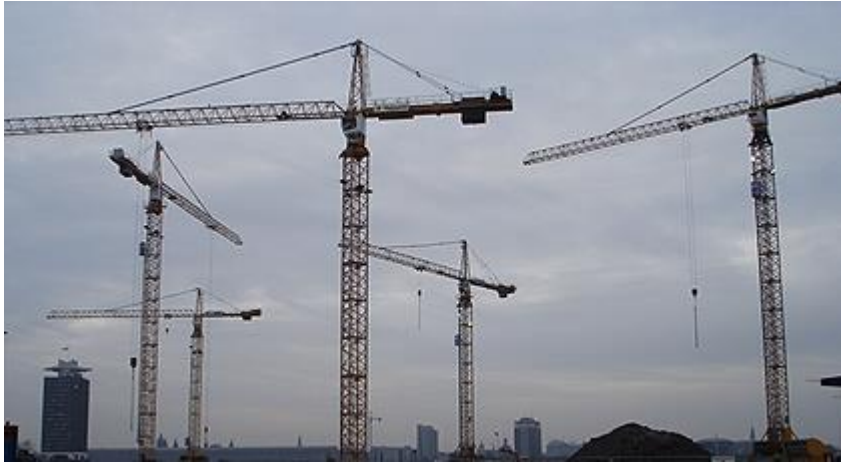
Figuur 4.7.1 Meerdere kranen op de bouwplaats
