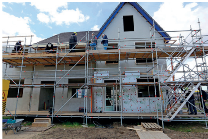
Leerlingen onder begeleiding op de steiger aan het werk. (foto Theo Annes)
